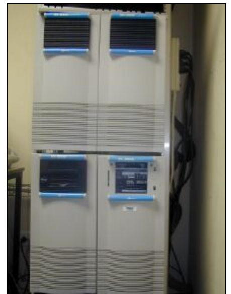
Imagen 5. Central telefónica Mitel
